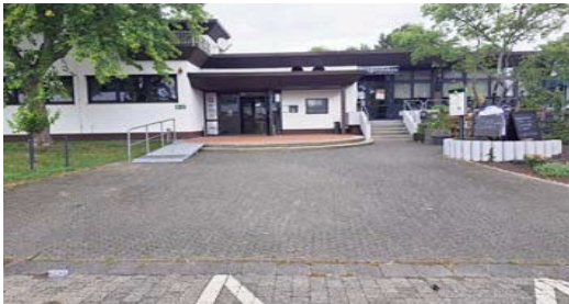
Eingang BGH / Gaststätte
