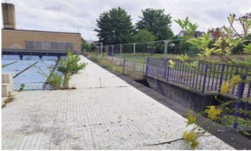
ehem. Hallenbad / südl. Freibereich
