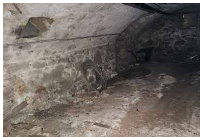
Blick in den großen Gewölbekeller Foto: Ch. Schmidt
